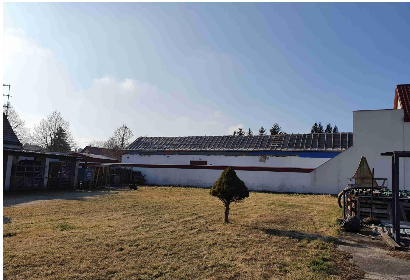
Travnatá plocha u č.p. 76, v průhledu za zdí bývalý hospodářský objekt č.p. 135
