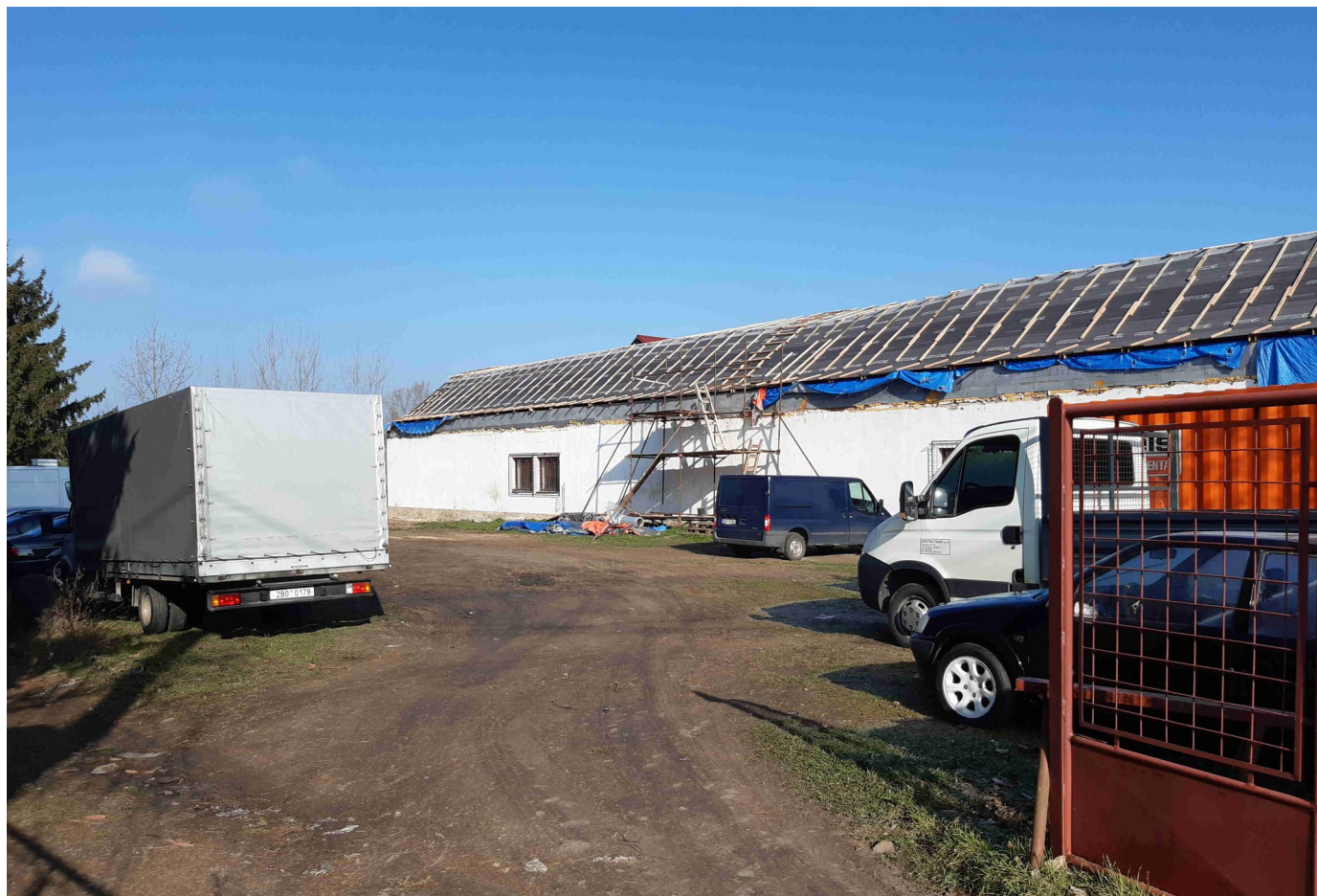
Zahrada přiléhající k autoservisu, bývalý hospodářský objekt č.p. 135
