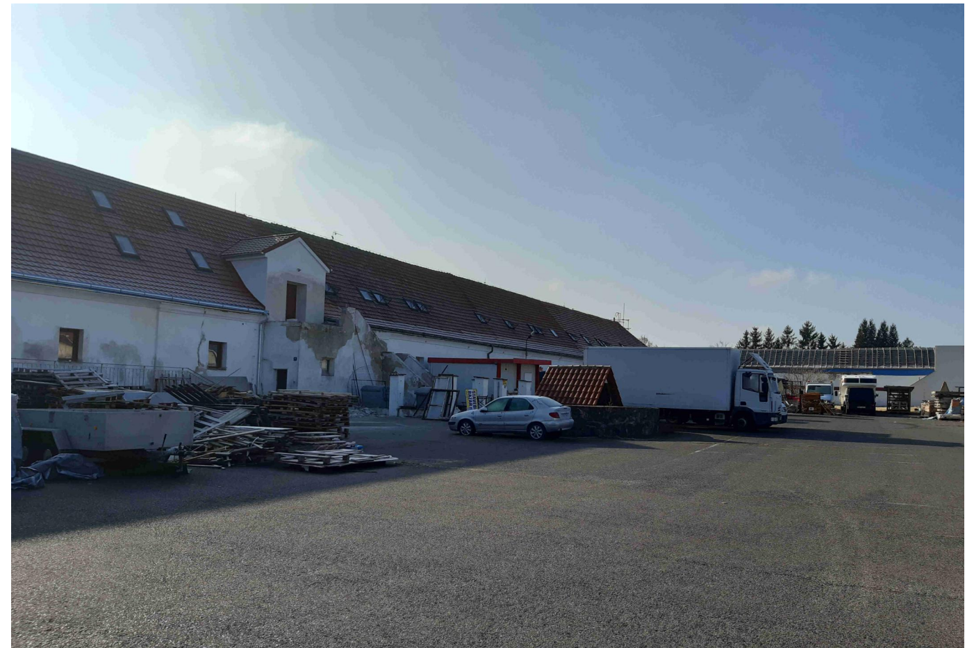
Zpevněná asfaltová plocha mezi č.p. 76 a zámekem, bývalý hospodářský objekt č.p. 76
